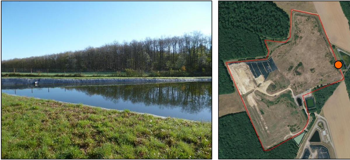
Figure 52 : Illustration d'un bassin de rétention/décantation des eaux présent sur le site
